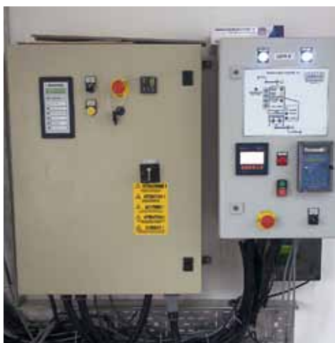
< Виконання щита управління сушаркою TORNUM безперервної дії моделі TK8-28-4
