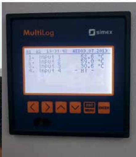
▲ Панель індикації значень температур зерна °С в зонах шахтної сушарки TORNUM
