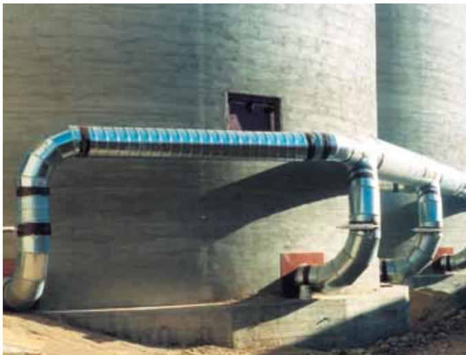
↑ Система пневмотранспортировки kanalsystem снижает потери зерна при перегрузках до 0,1%
